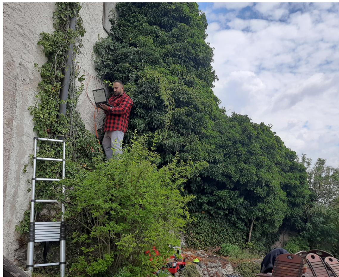
Abbildung 21: Alireza Madani bei der Messung von 2D-Geoeltrik (zur Feuchtebestimmung) neben und hinter dem Efeu
